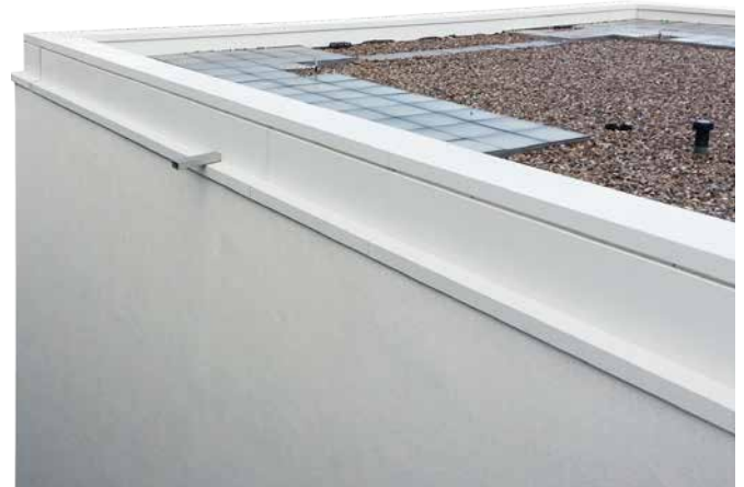
Krankenhaus in Hamburg-Volksdorf, pulverbeschichtete Attikaabdeckung und Fassadengesims
